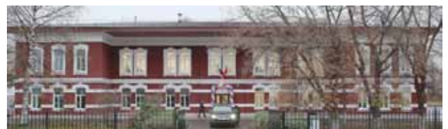
Здание Научно-производственного регионального инновационного центра машиностроения (НП РИЦ)
