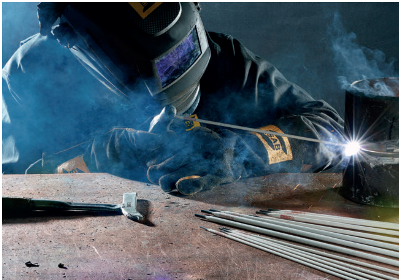
Рис. 2. Сварка штучным электродом
