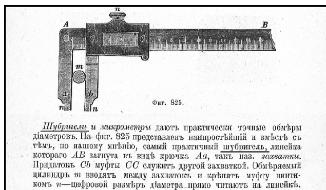
Рис. 3. Описание и вид обычного шубригеля на страницах «Техники черчения»
