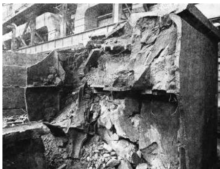
Рис. 1. Отливка стойки зубофрезерного станка, разрушенная в результате образования трещин, масса отливки 43 т
